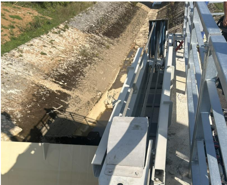
Elektrocilindar: Brzina otvaranja: 6 mm/s Vreme otvaranja 5,5 min za 2000 mm
