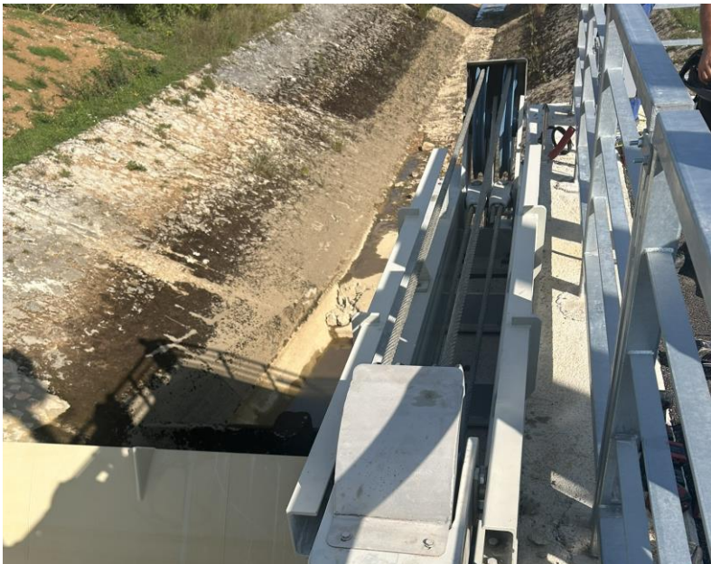
Elektrocilinder: Hitrost odpiranja: 6 mm/s Čas odpiranja: 5,5 min za 2000 mm
