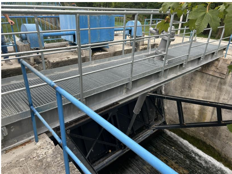
Elektro cilindar: brzina otvaranja: 5 mm/s vreme otvaranja 5 min za 1500 mm
