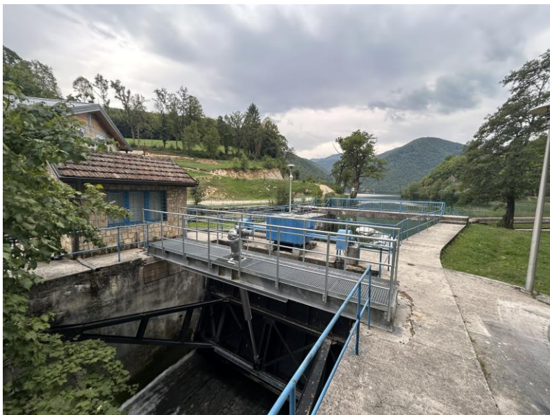
Segmentni zatvarač: hod 1,5 m; širina 6 m; visina 3,4 m;
