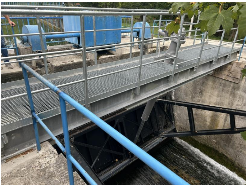
Elektrocilinder: hitrost odpiranja: 5 mm/s čas odpiranja 5 min za 1500 mm
